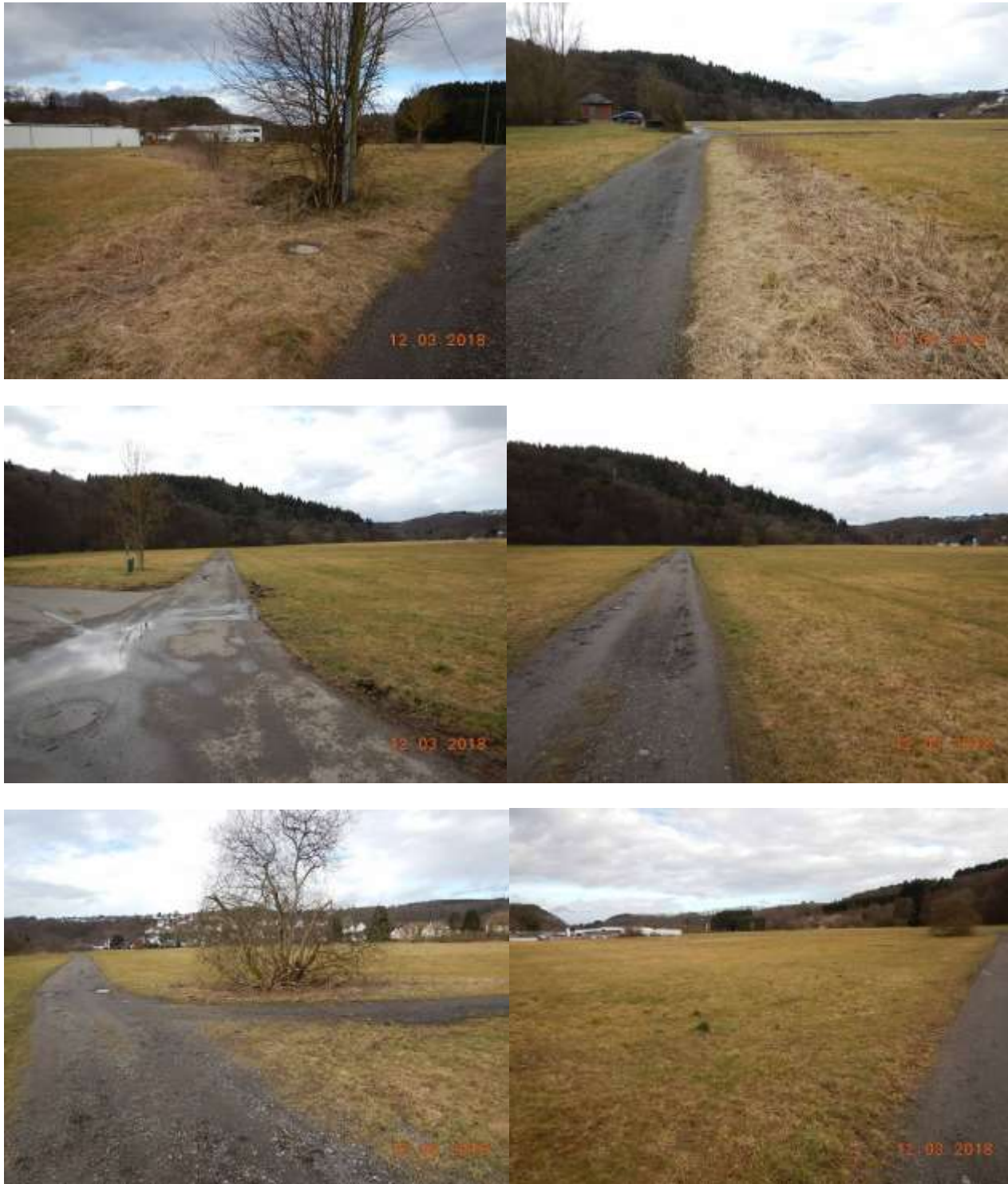
Abb. 1 bis 61: Übersicht über den geplanten Verlauf des Entwässerungsgrabens, welcher im Osten beginnt und in Richtung Westen hin zum geplanten Regenrückhaltebecken verläuft. Abb. 1 zeigt den Startpunkt im Osten, die folgenden Fotos den Verlauf nach Westen aus unterschiedlichen Blickrichtungen. Der Entwässerungsgraben wird nördlich entlang eines bestehenden landwirtschaftlichen Weges geführt (siehe Abb. 2 bis 5). Bei der Eingriffsfläche handelt es sich um einen großflächigen Grünlandbereich südlich der Ortslage von Oberlahr bzw. nördlich der Wied.
